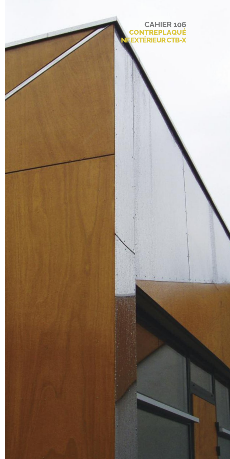
Figure 34 : Traitement des joints horizontaux entre panneaux
